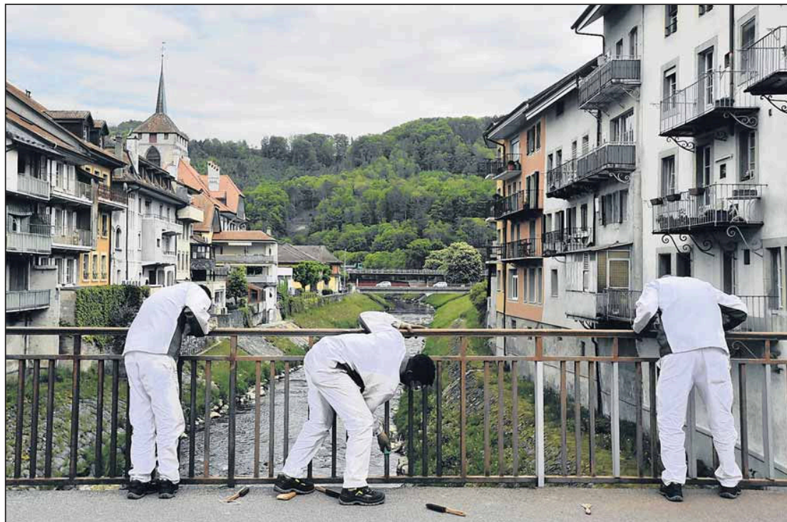
Les huit requérants, qui ont exercé des professions aussi diverses qu'électricien ou ferrailleur dans leur pays, découvrent le travail de peintre. Ils rénovent le pont Saint-Eloi, situé au cœur du bourg et qui date de 1898.
