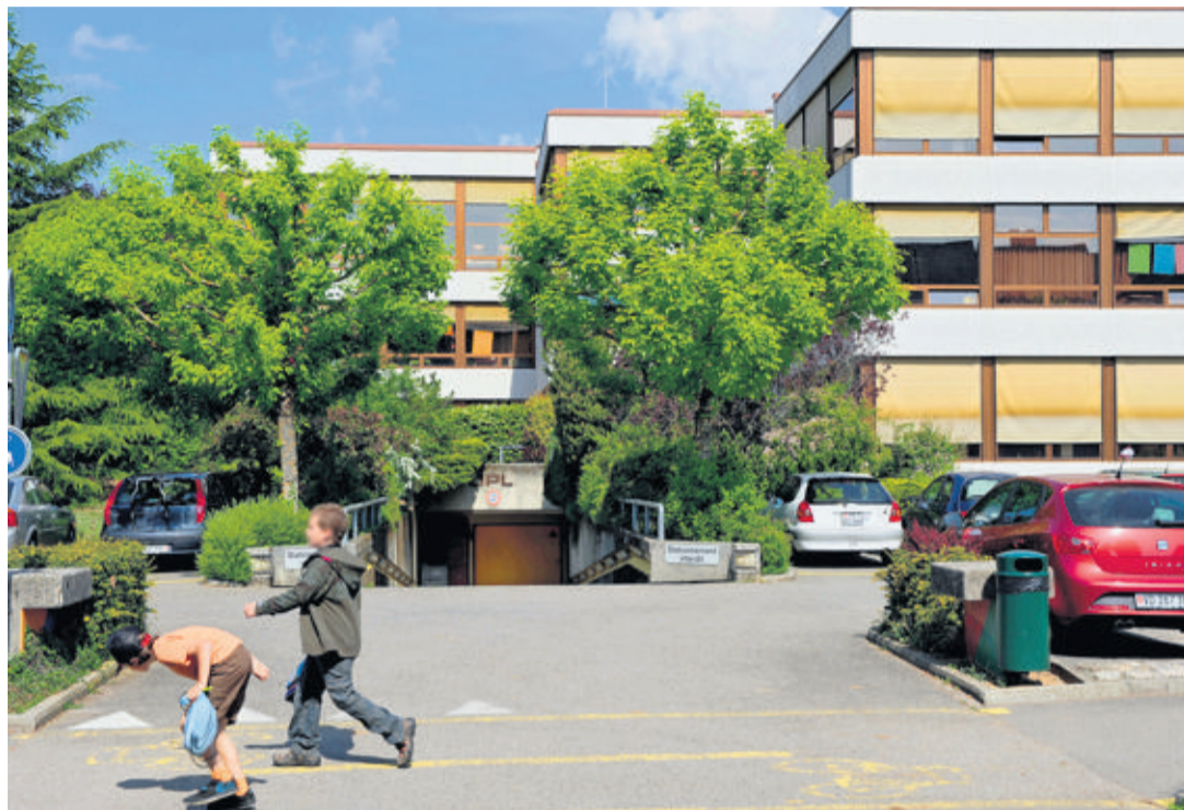
Gland doit ouvrir d'ici l'été son abri PCI du collège primaire des Perrereys, situé sous le parking des enseignants, pour une cinquantaine de requérants. PHILIPPE MAEDER
